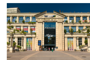
Réhabilitation CVC et CFo.CFa Galeries Lafayette Montpellier
