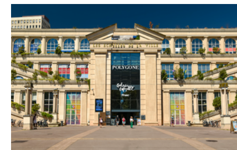
Réhabilitation CVC et CFo.CFa Galeries Lafayette Montpellier
