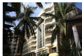
Construction Hôtel 5* King Fahd Palace à Dakar
